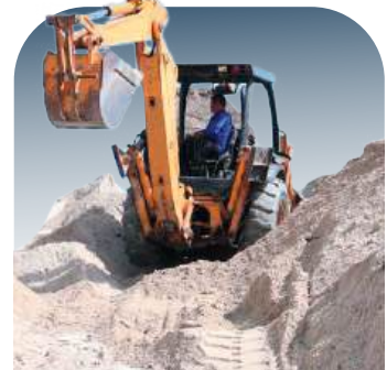
Limpieza, reconstrucción y nivelación de playas (colocación de arena y delimitación).
